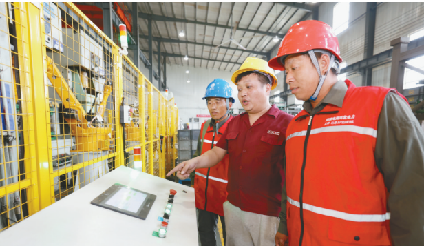
近日，国网新河县供电公司组织人员加大供电设备巡查力度，及时消除安全隐患。郝德明、李世强摄
