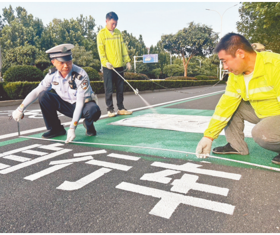
9月3日,交警与施工人员在泉北大街对非机动车道进行分道标线施划。为推进市区慢行交通系统建设,我市将部分路段按照车速功能划分为电动自行车道和自行车道,规范非机动车通行秩序。张驰摄
