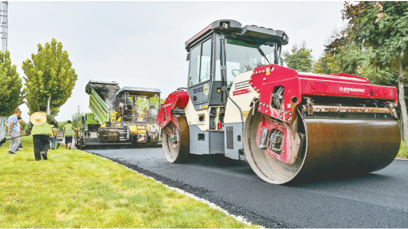
8月11日，牛尾河营地公园项目进入施工收尾阶段。该公园位于牛尾河骑行绿道起点附近，建成后将与沿线绿道串联，为骑行爱好者提供更优质的休闲运动空间。
