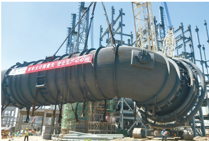
邢钢转型升级搬迁改造项目炼铁熔融还原炉汽化冷却烟道安装现场。赵国华摄
