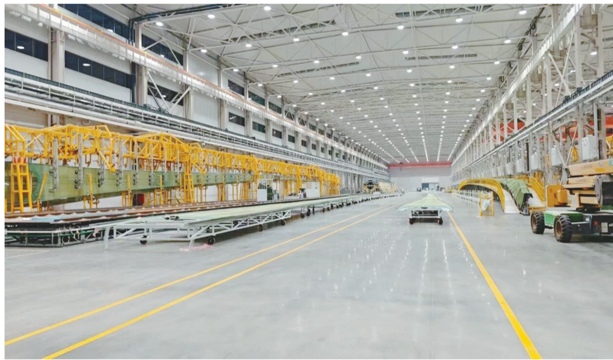
图为中车集团新能源装备基地项目风机叶片生产线。
