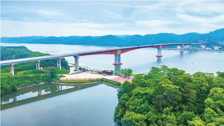
广西飞龙大桥（世界最大跨径1800型波形钢腹板组合梁）
