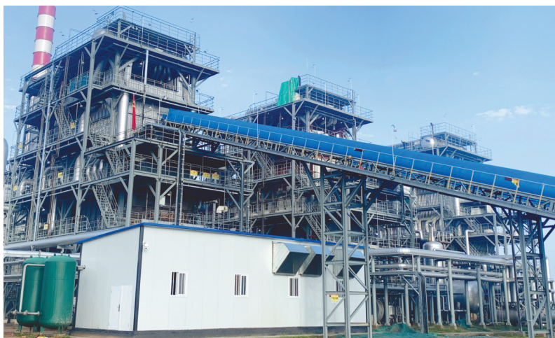
图为京津落地项目——国能新河生物质工业供热项目建设现场（资料图片）
